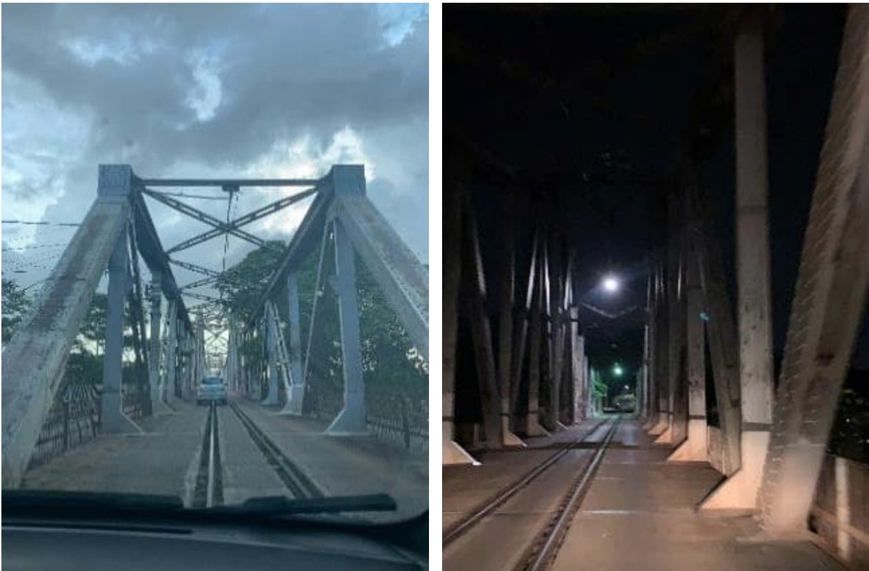
Figura 12 – Composição de imagens da Ponte Metálica
