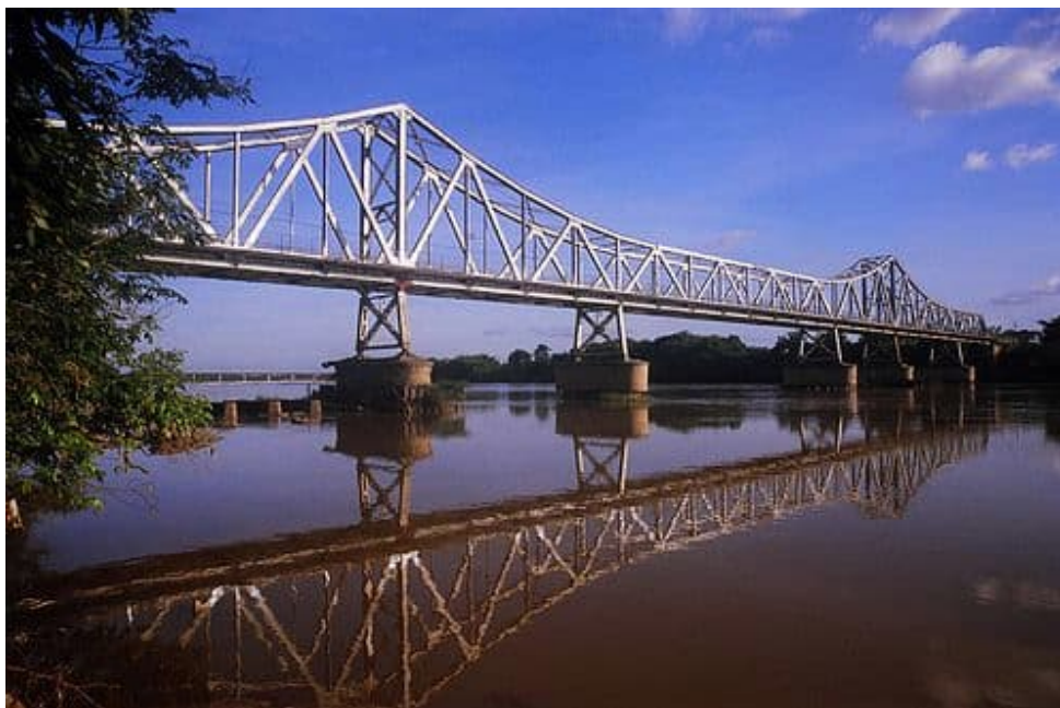
Figura 13 – Imagem panorâmica da Ponte Metálica
